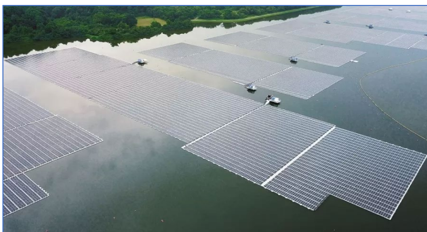
Figura 52 - Vista aérea do novo parque de energia solar flutuante da empresa de energia Sembcorp no reservatório de Tengeh em Singapura.
